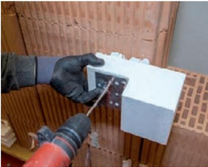
Les volets pliants et coulissants peuvent être fixés facilement sans pont thermique sur le mur extérieur ou dans l'embrasure au moyen du bloc de montage **CF 200** – même en cas de couches isolantes épaisses. Le bloc peut être intégré sans difficultés dans les systèmes ETICS et recouvert de plâtres.
