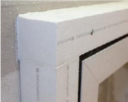
Avec le SYSTEME KLIMA KONFORM 2.0, les fenêtres peuvent être intégrées directement dans la couche d'isolation, ce qui permet de créer des raccords muraux sans pont thermique.
